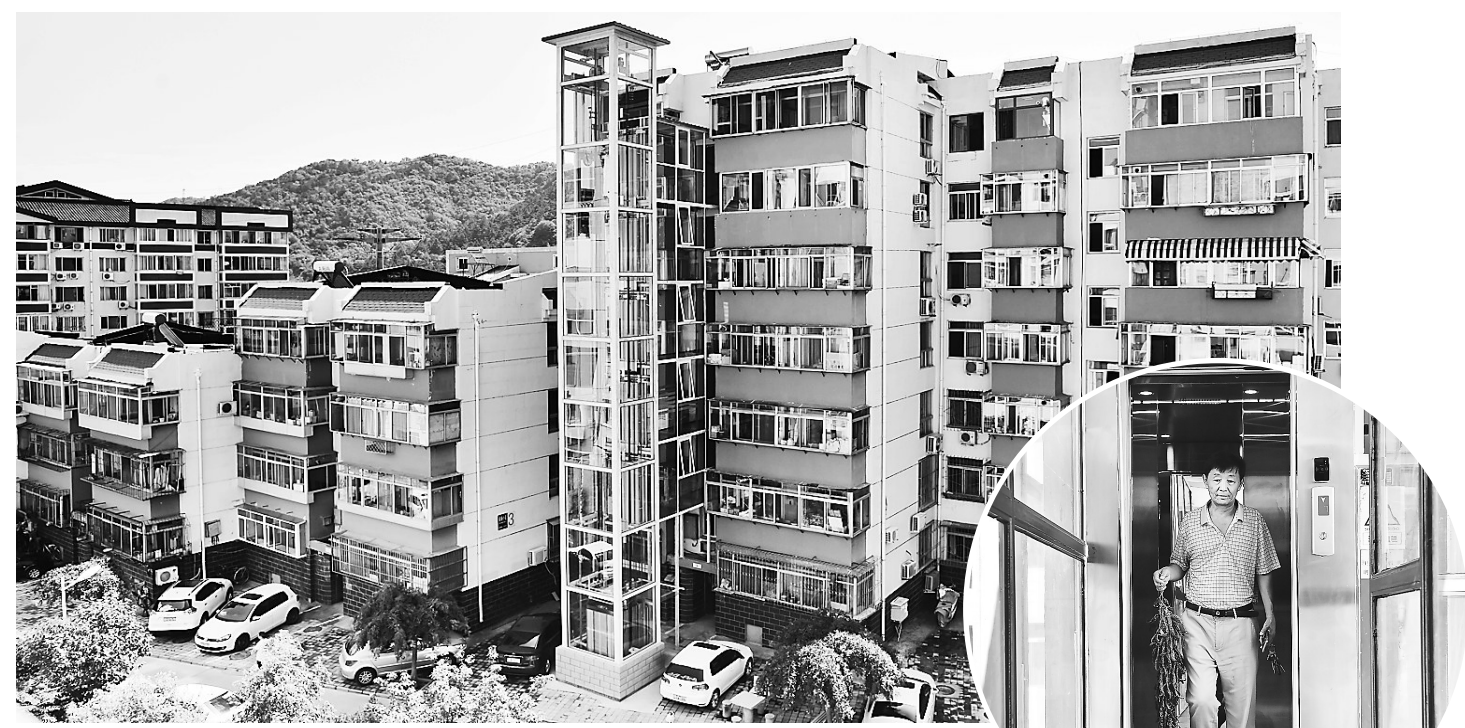
8月23日,双桥区山庄社区柴场小区部分居民楼加装电梯后,居民出行更加便捷。今年以来,该区坚持以居民为主体,让居民参与到老旧小区改造提升的全过程中,实现老旧小区共商、共建、共管、共享。目前,该区已对21个老旧小区实施了改造。记者 田明 霍艳恩摄
