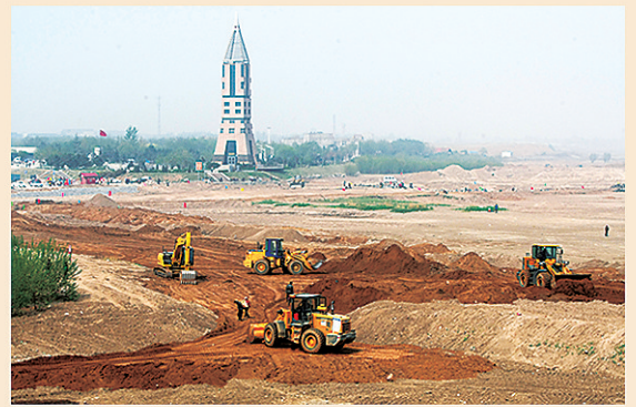
下图: 2012年4月, 施工人员在加紧进行滹沱河综合整治。
