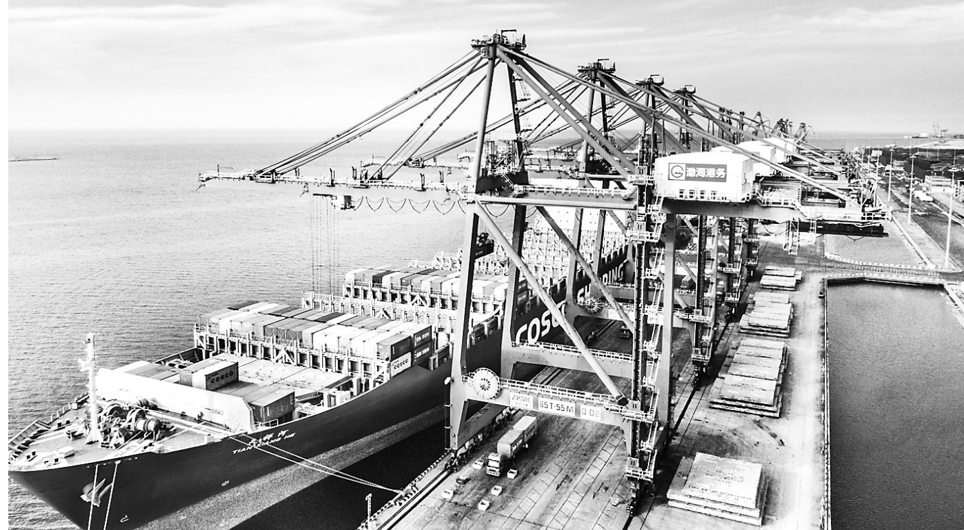
今年前8个月,黄骅港吞吐量累计完成1.9亿吨,同比增长3%,集装箱完成52.2万标箱,同比增长28.8%,继续保持稳定、快速发展态势,增速连续位居全国沿海主要港口首位。图为正在作业中的黄骅港集装箱码头。 通讯员 张建跃摄
