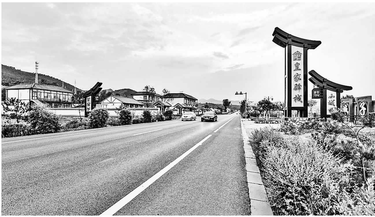
今年,滦平县通过大力实施美丽乡村建设工程,在200个行政村实施亮化工程,实现主村主街路灯灯杆全覆盖,同时对35个贫困村实施农村面貌整体改造提升。这是滦平县美丽乡村建设一角。 记者 尉迟国利 通讯员 郭晓芬摄
