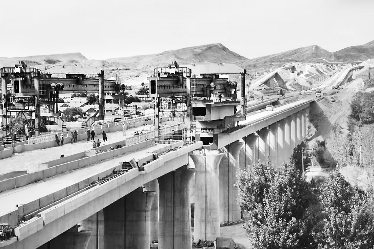
10月8日,经过436天艰苦奋战,由中铁二十局承建的2022年冬奥会重点配套工程——京张高铁崇礼支线519孔箱梁架设工作圆满完成。崇礼支线全长53公里,设计时速250公里,自下花园北站引出直达崇礼太子城奥运村,预计2019年底前建成通车。 记者 高振发 通讯员 院玉顺摄
