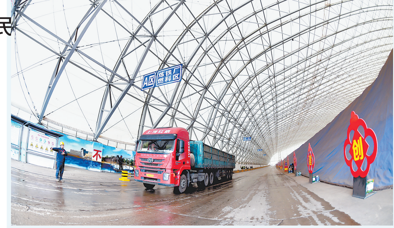
10月21日,一辆运料车驶出国内首家、世界最大跨度单体异形PE膜结构封闭料场。日前,德龙钢铁有限公司投资1亿多元的封闭料场建成。该料场南北长226.8米,东西长423.6米,封闭面积87400平方米,年可削减无组织扬尘2601吨。记者 赵永辉摄
