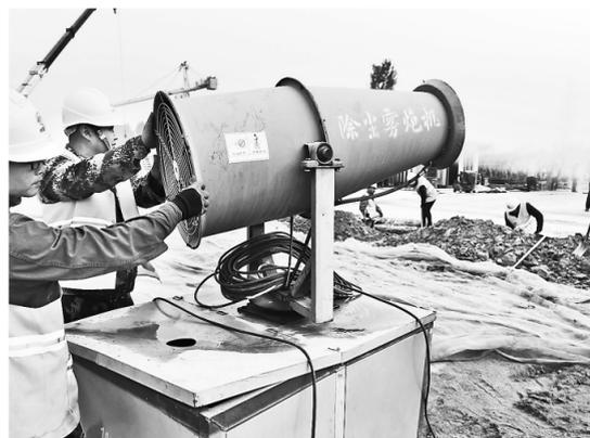
近日，中铁十七局三公司在石家庄地铁东庄站施工中采用除尘雾机降尘作业，同时采取密网遮盖、湿法作业等措施，减少施工扬尘对周围环境的影响。记者 陈建宇 通讯员 史晓帆摄
