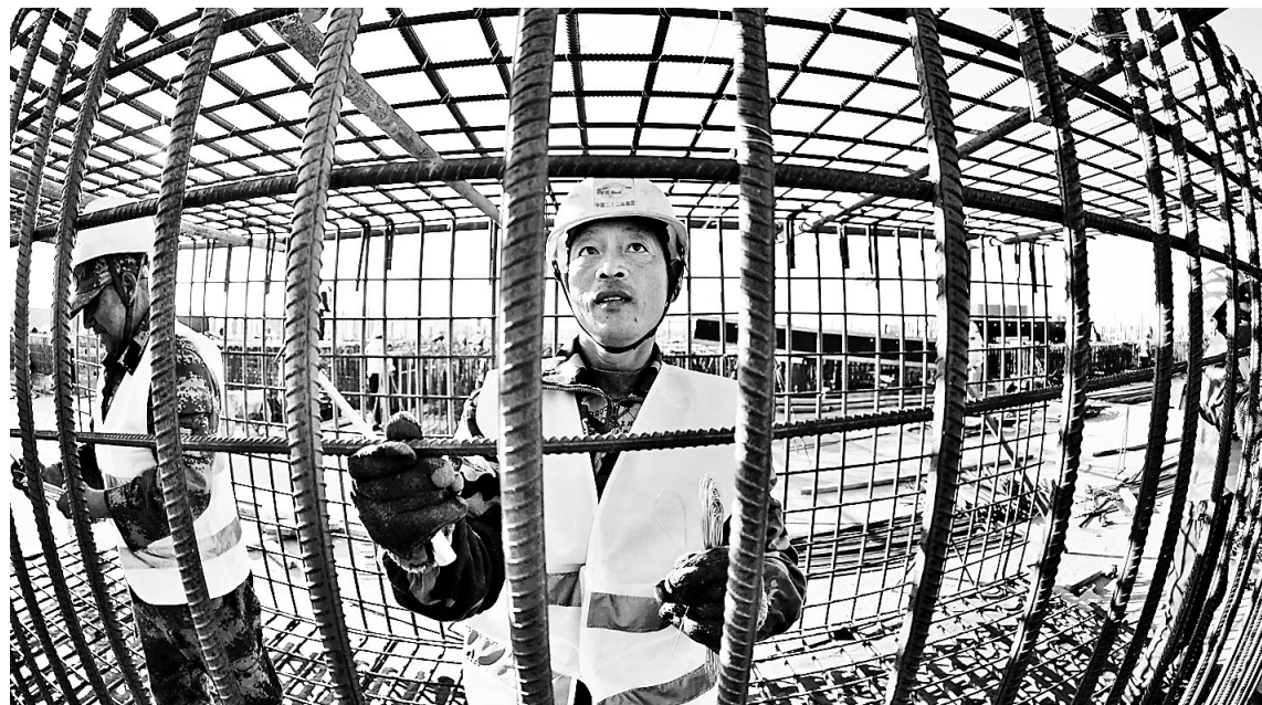
目前,唐山港京唐港区智慧集装箱码头项目正在加紧施工。这是施工人员在现场作业。该项目设计年通过能力为集装箱120万标箱,预计2019年2月底基本完工并投入试运行。
