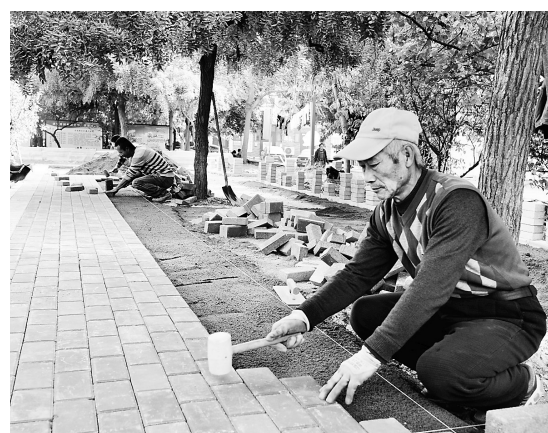
近日,施工人员在老旧小区路面进行硬化。日前,北戴河区持续实施老旧小区基础设施改造提升工程,针对部分建设年代久远、基础设施陈旧的老老旧小区,重点实施路面硬化、管网维护等改造提升工程。 通讯员 张悦摄
