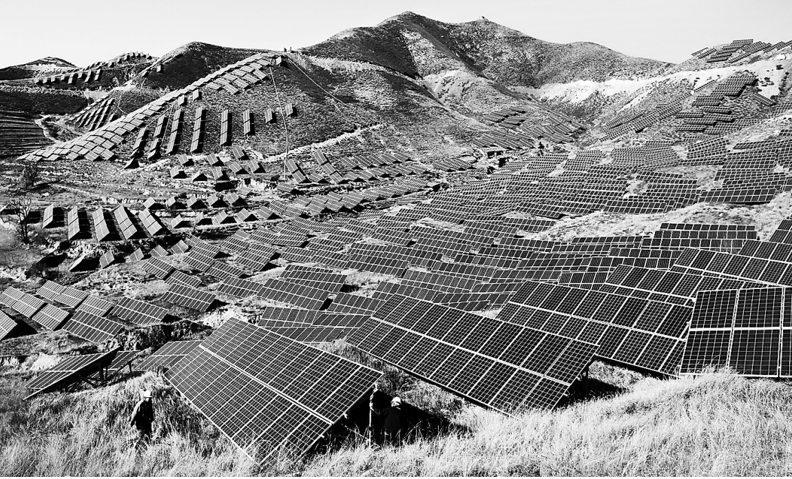
赤城县大力发展光伏扶贫产业,目前全县已建成集中式光伏扶贫电站3个,扶持2800户贫困户;完成村级光伏扶贫电站39个,扶持贫困户2340户。这是日前在该县田家窑镇二道洼村光伏扶贫电站基地,工人在巡检太阳能板。
