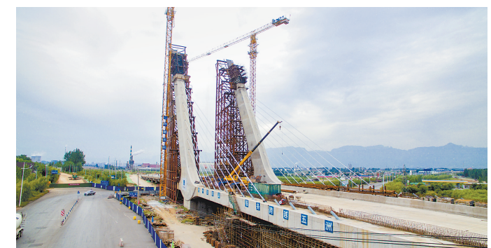
日前,由中建路桥集团(原河北路桥集团)承建的混凝土箱梁单孔跨径为亚洲最大的林州迎宾大桥(无背索双塔面独塔斜拉桥)主体工程完工。该斜拉桥混凝土箱梁主跨单孔跨径达80米,为目前亚洲最大跨径。 通讯员 焦利英摄
