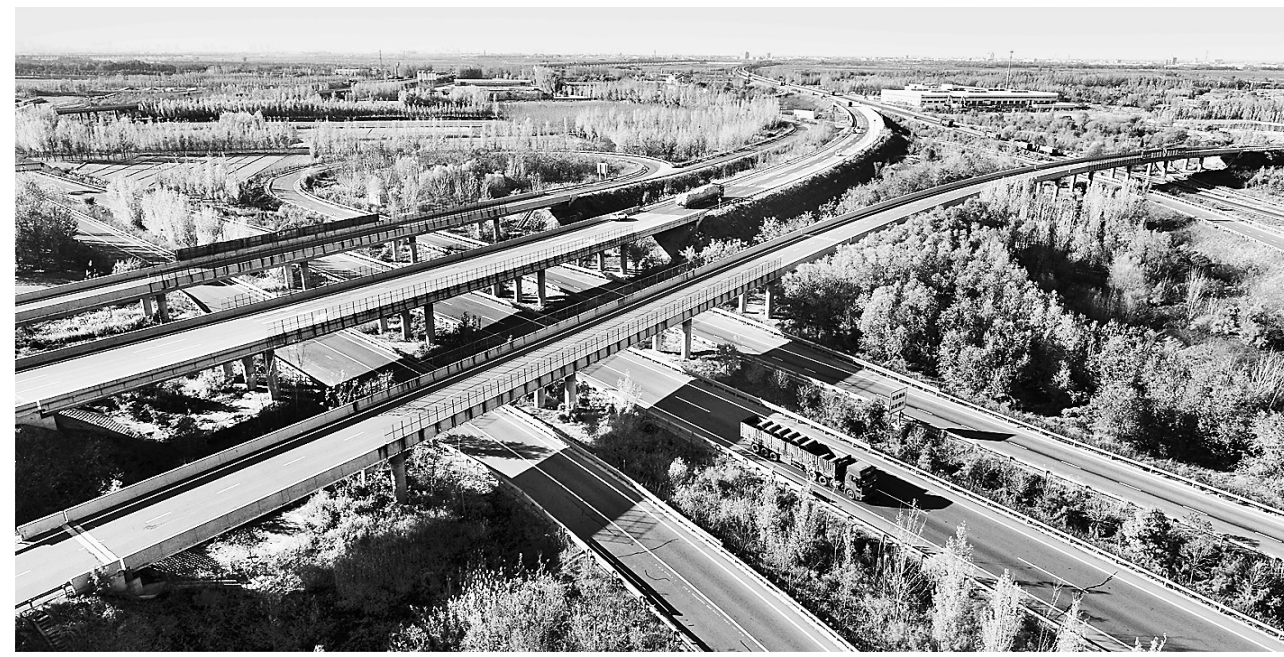
近年来,衡水抢抓京津冀协同发展机遇,大力推动交通一体化建设,为深度融入京津冀大交通网络奠定坚实基础。这是大广高速和衡德高速交汇处,高速互通桥纵横交错,贯通南北东西。
