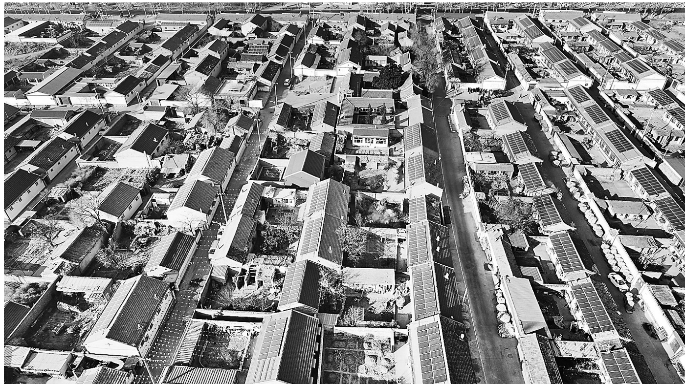
怀来县存瑞镇义合堡村被称为“新能源环保小镇”。2016年该县将义合堡村作为试点村,安装地源热泵和光伏发电板,实现光伏发电与地源热泵优势互补,环保效益显著。目前,该村265户居民通过使用地源热泵和光伏发电,年节约燃煤1000多吨,每户还有2000多元的收入。这是12月14日航拍的义合堡村全景。
