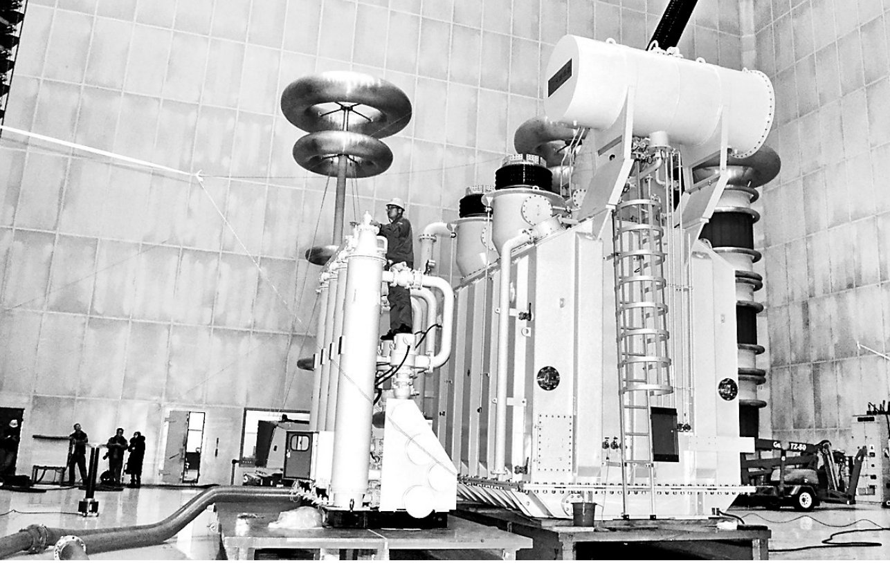
近日,天威保变(秦皇岛)变压器有限公司成功完成金沙江乌东德水电站用500kV主变压器首台产品的性能试验。这是公司技术人员对500kV主变压器进行性能检测试验。该公司将生产38台500kV主变压器用于金沙江乌东德水电站项目,预计2019年完成全部产品的交付。 通讯员 李佳新 摄
