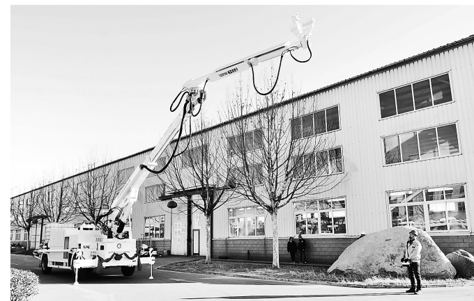
日前,两台用于隧道施工的喷浆机械手设备在河北途程隧道装备有限公司调试完毕,并起运发送。喷浆机械手设备可有效解决隧道施工喷浆作业中出现的问题,已应用于全国多个项目建设。这是工作人员在调试喷浆机械手设备。 通讯员 王勤 摄
