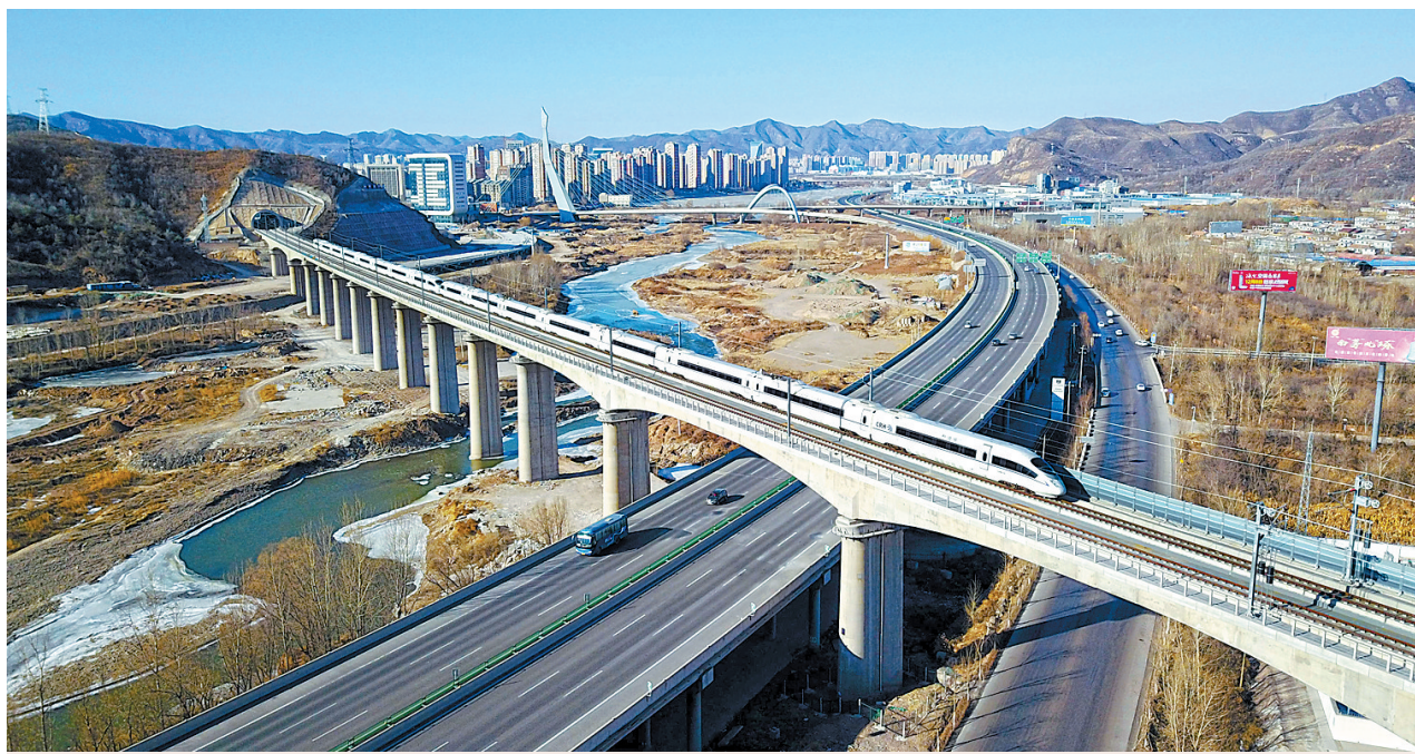
12月29日,京哈高铁承德至沈阳段开通运行,标志着承德进入高铁时代。图为G4255次高铁列车从承德南站出发经过滦河3号特大桥,驶往沈阳方向。 记者 田明摄
