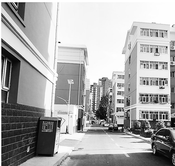
桥东区学院路小区改造前后对比图。张家口市住建局供图
