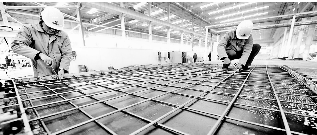
近日,位于文安县的北京建工新材恒均科技公司员工在对铺好的钢筋进行绑扎。文安县优化营商环境,引进高精尖项目落户。目前,已吸引20多家京津企业入驻。
