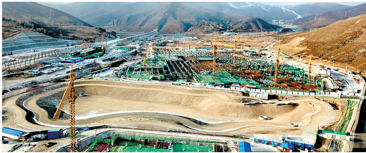
2022年冬奥会张家口赛区配套项目 崇礼太子城小镇建设工地(2018年12月19日摄)。新华社记者 杨世尧摄
