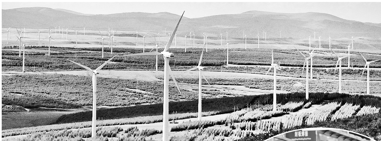
围场坝上百万千瓦风电基地一角。
