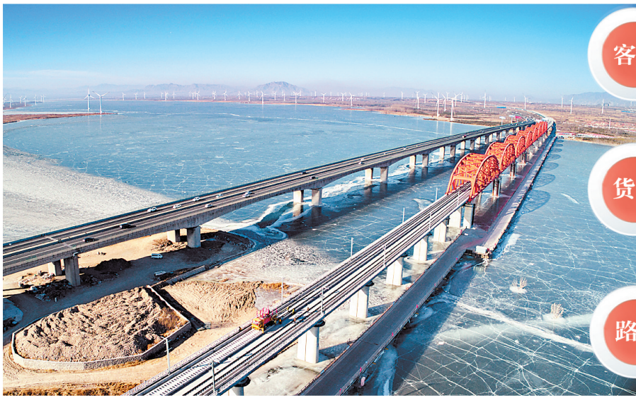
京张高铁官厅水库特大桥正在进行铺轨作业(1月13日无人机拍摄)。新华社发
