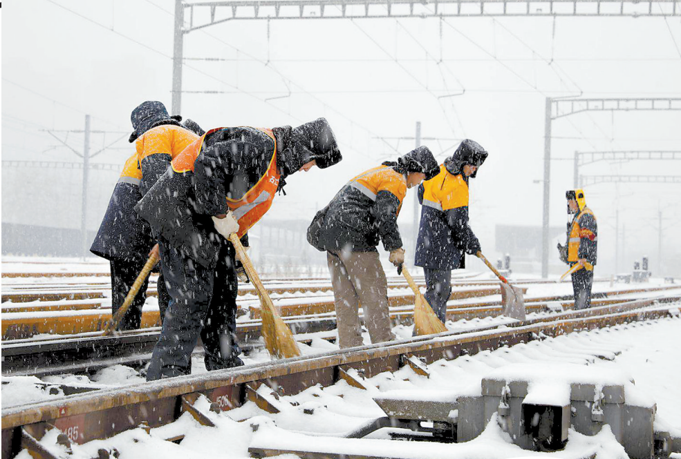
▲2月14日,石家庄工务段组织干部职工冒着降雪和严寒,积极做好铁路线路设备除雪、检查、检修等工作,确保春运列车安全畅通。通讯员 楚晓摄
