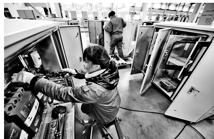
日前,南和县金江电股份有限公司扶贫车间在贫困人员中聘用的工人在组装配电箱。南和县在扶贫工作中,因地制宜设置扶贫车间,让贫困人员就近就业增加收入。目前,该县已建立扶贫车间14个,帮200余名贫困人员实现就业。记者 杜柏桦 通讯员 胡长祥摄
