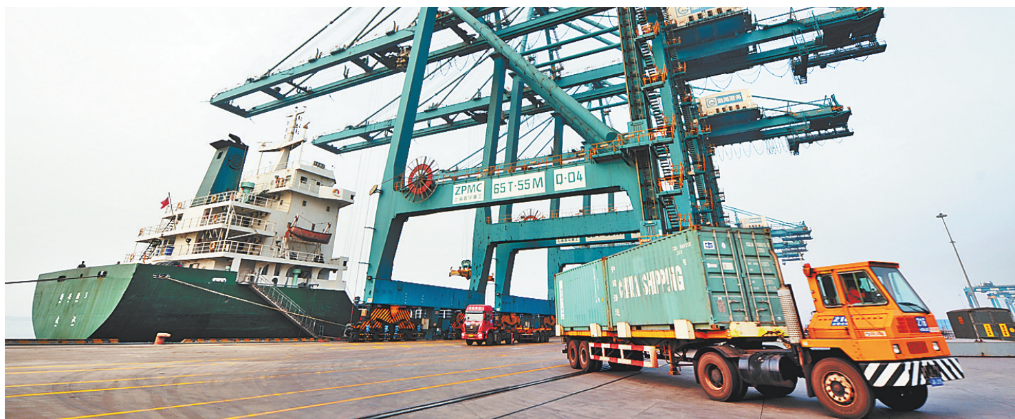
近日的黄骅港综合港区集装箱码头作业现场。
