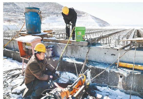
近日,延崇高速公路怀来段的工人正在紧张施工。延崇高速公路是京津冀一体化西北高速通道之一,也是2022年北京冬奥会重大交通保障项目。延崇高速公路河北段全长约114公里,预计今年年底竣工通车。 记者 刘雅静 通讯员 孙慧军摄
