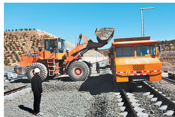
近日,由中铁二十局二公司承建的崇礼铁路线补砟工程正式复工。崇礼铁路正线全长53公里,设计道砟15.5万立方米,目前已铺底砟、补砟6.5万立方米。图为建设者在崇礼铁路下花园区段加紧补砟施工。 记者 李艳红 通讯员 曲志忠
