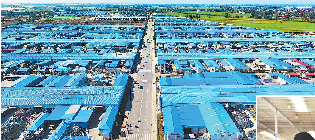
◀在定州市南辛兴村南侧,北方(定州)再生资源循环利用基地从废弃的沙荒地上拔地而起,蓄势待发。
