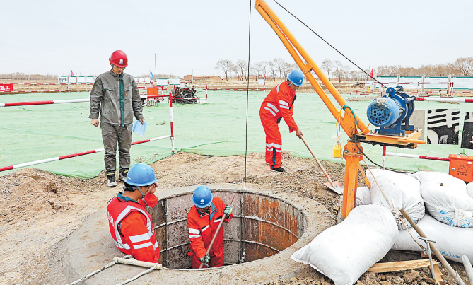
4月29日,工人在张北至雄安1000千伏特高压交流输电工程张北县二泉井乡1000千伏特高压变电站建设工地施工。新华社记者 杨世尧摄
