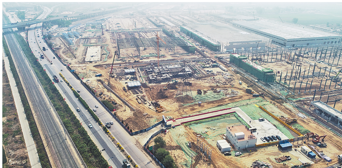
这是河北北京车项目建设现场。通讯员 罗大庆摄
