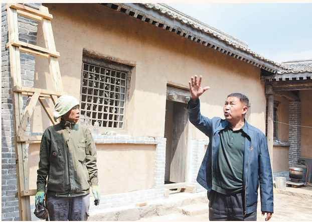
图为陈春芳(右)在车谷砣村晋察冀边区造币厂旧址恢复施工现场。 通讯员 李学彦摄
