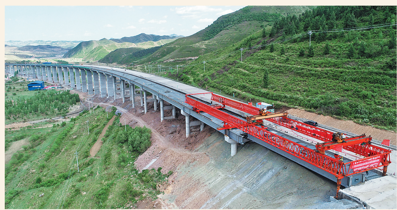
延崇高速公路西水沟特大桥钢梁全部架设完成
