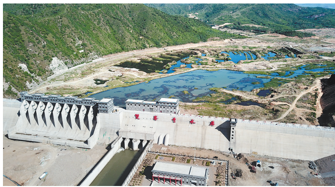
5月31日,双峰寺水库正式下闸蓄水。图为双峰寺水库大坝。通讯员 王立群摄
