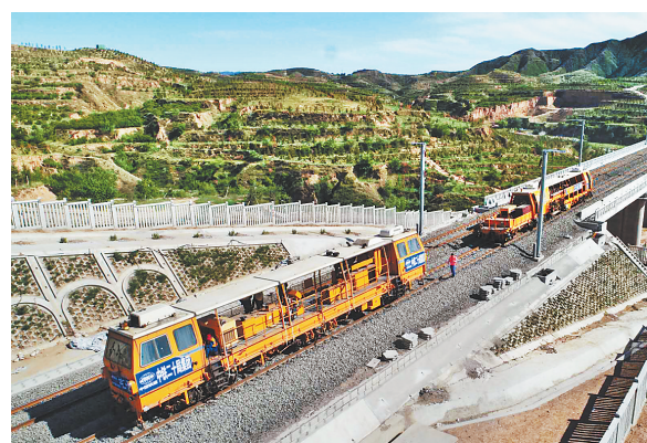
近日,由中铁二十局承建的2022冬奥重点配套工程——崇礼铁路翰林庄1号大桥有轨轨道无缝焊接顺利完成。据悉,该桥全长548米,是崇礼铁路首座率先完成长轨稳定焊接的大桥。 通讯员 曲志忠 记者 李艳红
