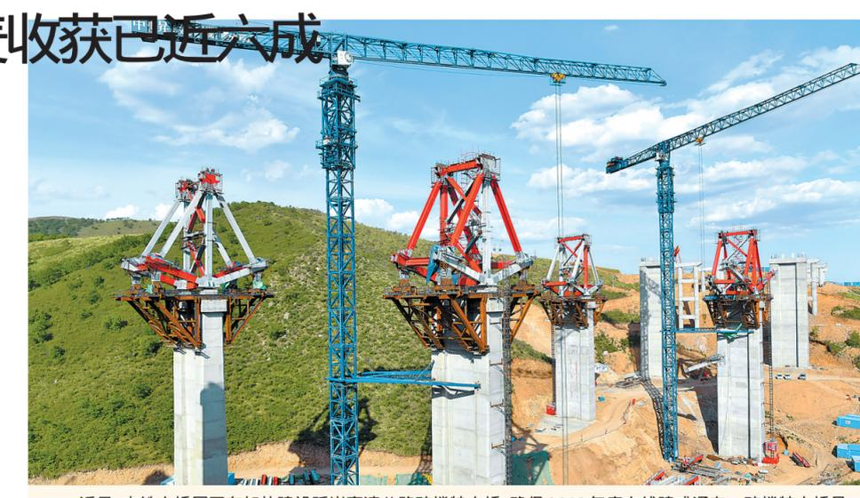
近日,中铁大桥局正在加快建设延崇高速公路砖楼特大桥,确保2019年底主线建成通车。砖楼特大桥是延崇高速公路河北段的重要控制性工程,大桥为左右幅分离方式,单幅桥梁长1068.5米。通讯员 李英军 关伟鹏摄
