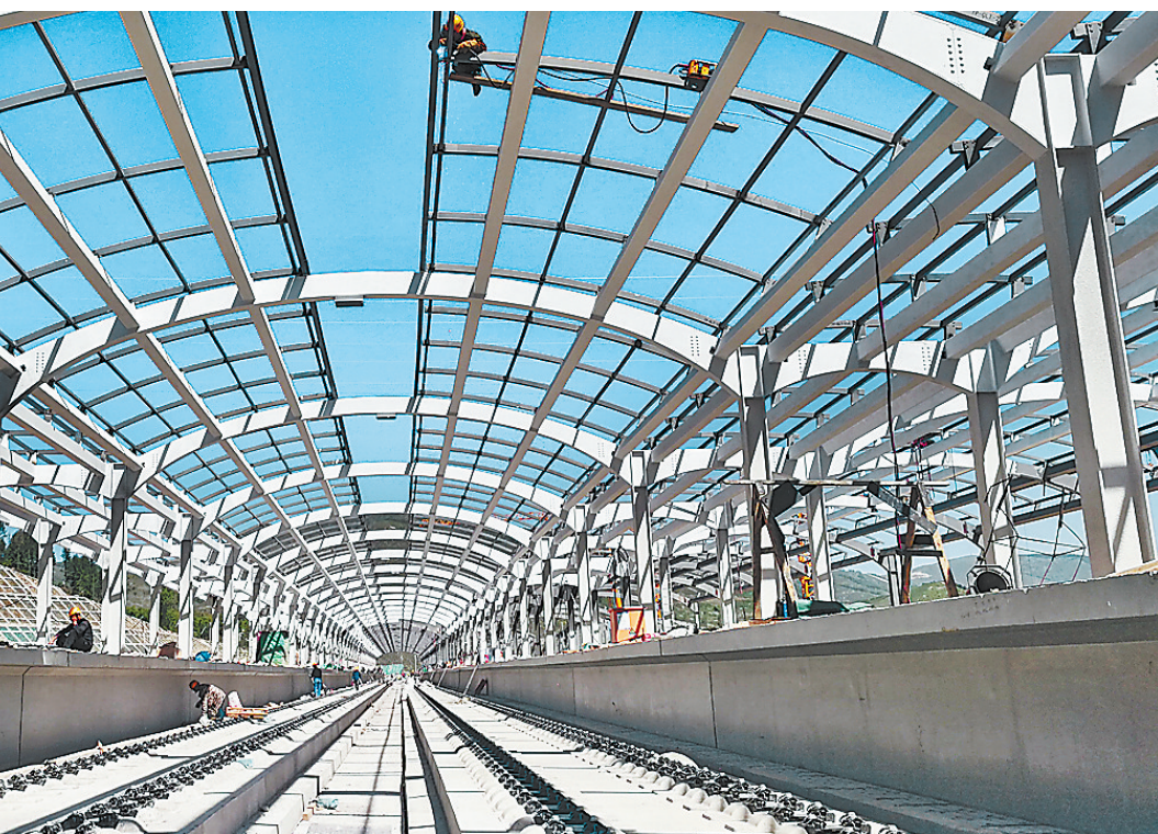
日前,北京2022年冬奥会重点配套工程崇礼铁路太子城段建设工程进入无砟轨道施工阶段,现在各项工作正在紧张有序推进中。崇礼铁路太子城段包括太子城隧道、太子城车站和太子城特大桥,属于中铁四局崇礼铁路三标段内建设项目。图为建设者在太子城车站施工。
