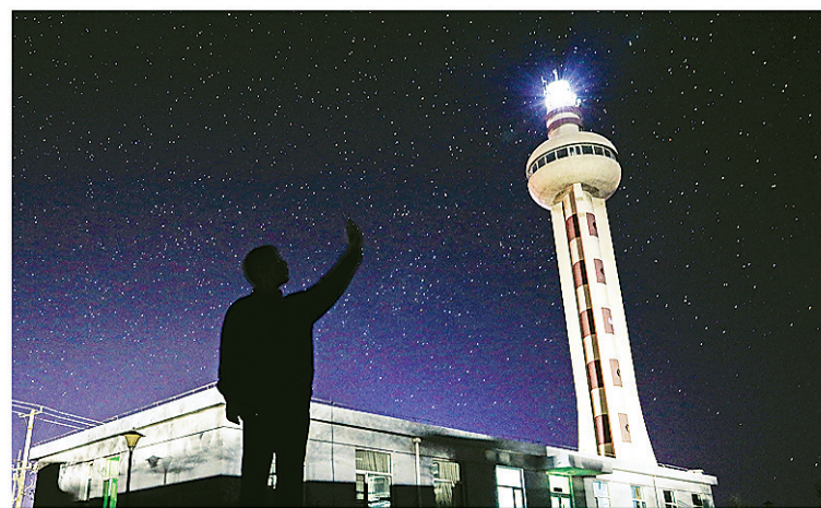
王同林用视频记录灯塔灯光的闪烁间隔,用来确认灯器是否工作正常。
