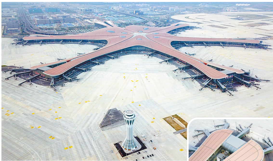
▲6月25日无人机拍摄的北京大兴国际机场西塔台和航站楼。
