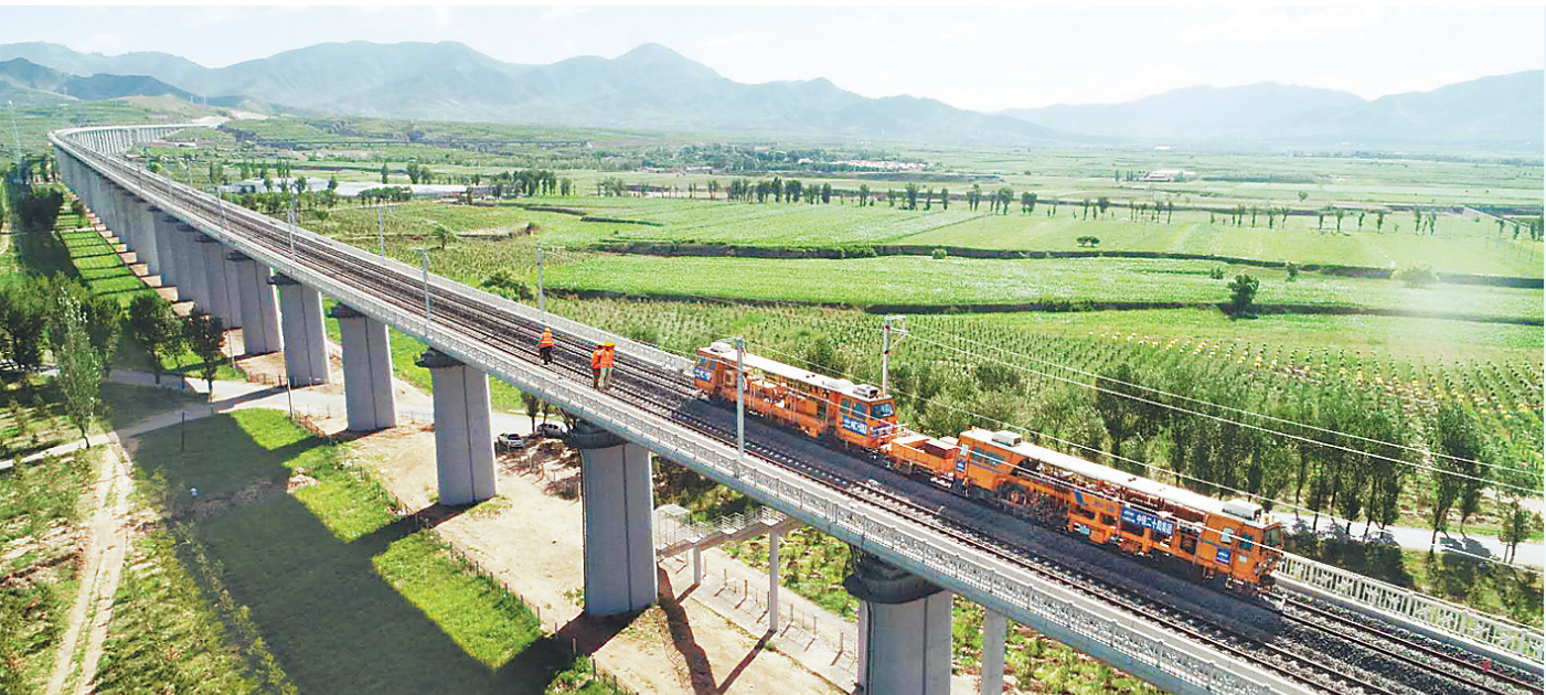
6月30日,由中铁二十局承建的北京2022冬奥会重点配套工程崇礼铁路全线最长特大桥——赵川镇高架特大桥长轨起道顺利完成,为9月联调联试奠定了坚实基础。该桥位于张家口腹地,全长7.8公里。此次作业克服了在千米之三大坡度桥面上施工的诸多技术难题。图为大型设备当日在特大桥上起道最后300米有砟轨道。 通讯员 曲志忠 记者 李艳红摄
