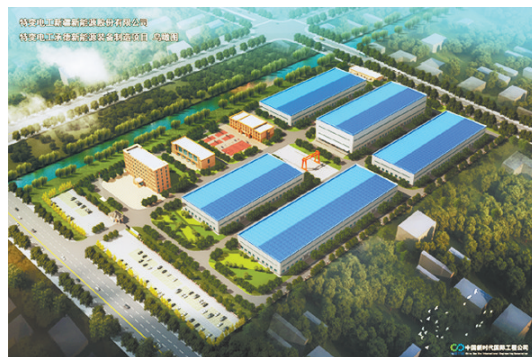
特变电工承德新能源装备制造项目。
