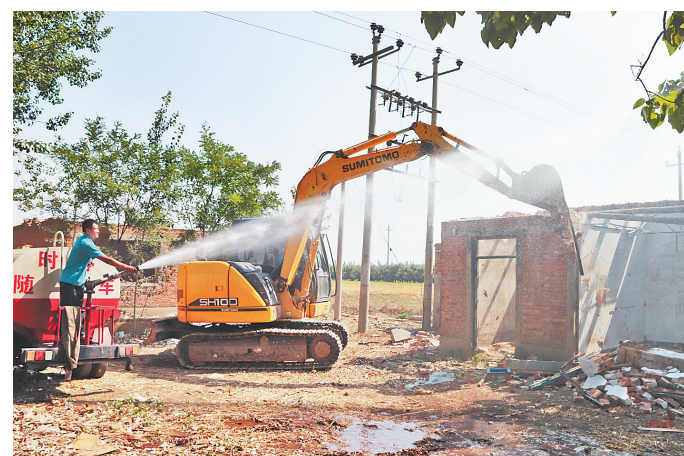
日前,辛集市重拳出击,打响县道天网线拆迁攻坚战役,对该路段沿线的私搭乱建、违章建筑进行集中统一拆除。 通讯员 房晓坤摄
