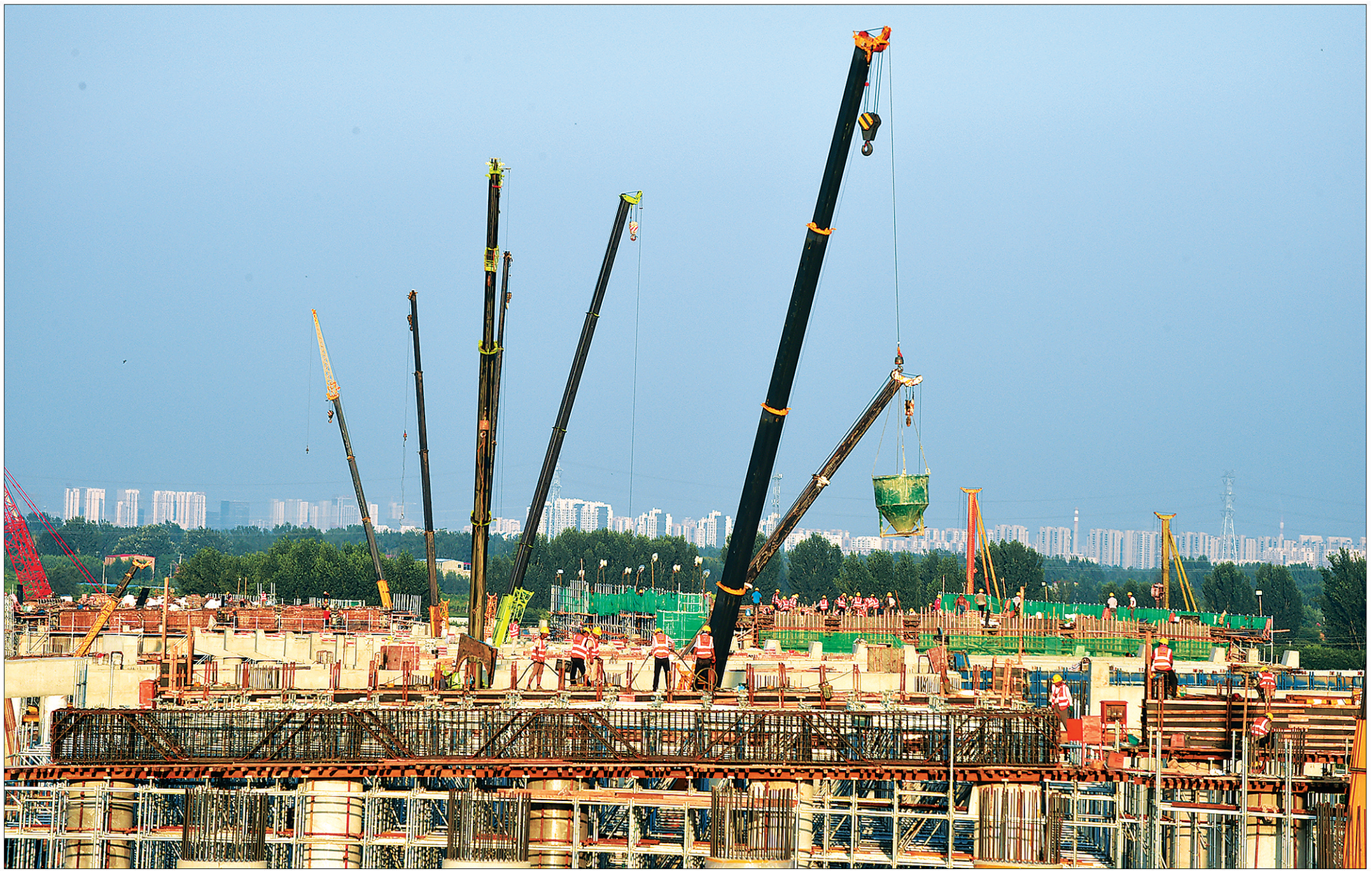
在施工现场,建设者顶高温、战酷暑,处处可见热火朝天的建设场景。
