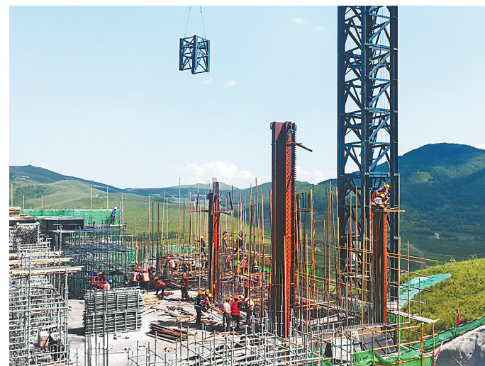
在工程量最大、技术难度最高的冬奥会竞赛场馆——国家跳台滑雪中心“雪如意”工地,建设者们正在紧张施工。据介绍,截至7月底,该项目工程已完成顶峰俱乐部60%工程量、滑道区90%工程量、看台区50%工程量。 记者 刘雅静摄
