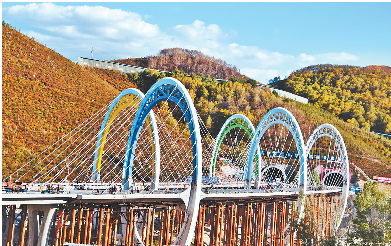
日前,延崇高速太子城斜拉桥、冰雪五环桥基本完成主体结构施工。该桥是双幅五拱塔钢结构斜拉桥,造型为奥运五环,如同冰雪凝聚的五道环形桥塔,适应地形和分幅布置的需要,实现形式和功能的统一。
