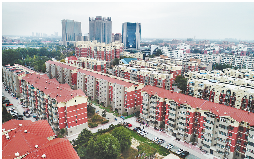
憩园小区改造工程完工后面貌焕然一新。 通讯员 侯子清 记者 孟宪峰摄
