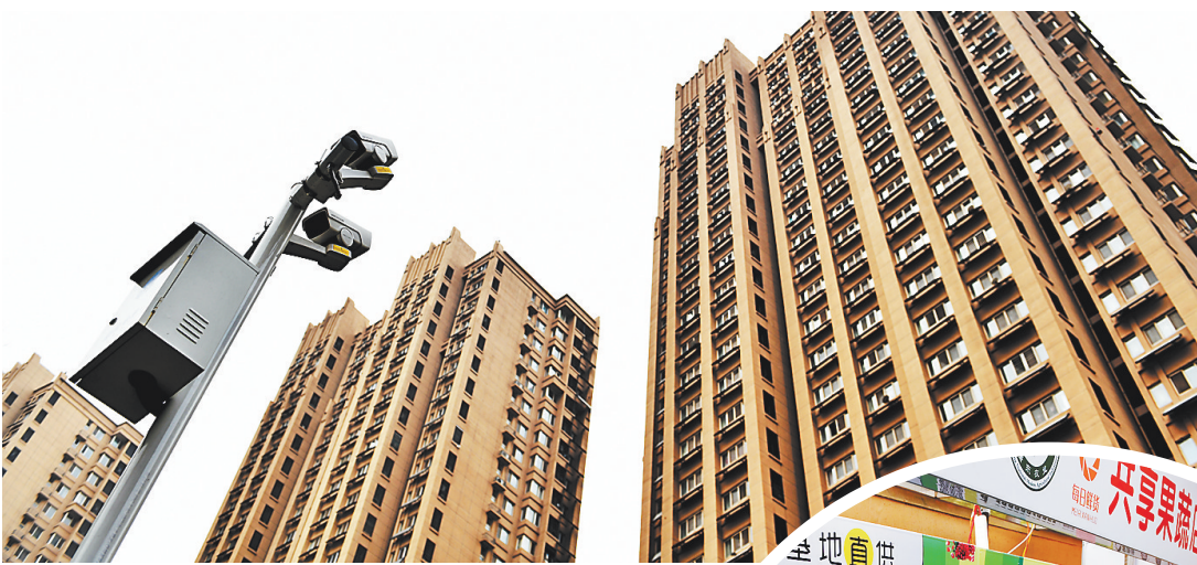
▲广厦苑小区防高空抛物摄像头可对楼体高空抛物进行24小时实时监控。
