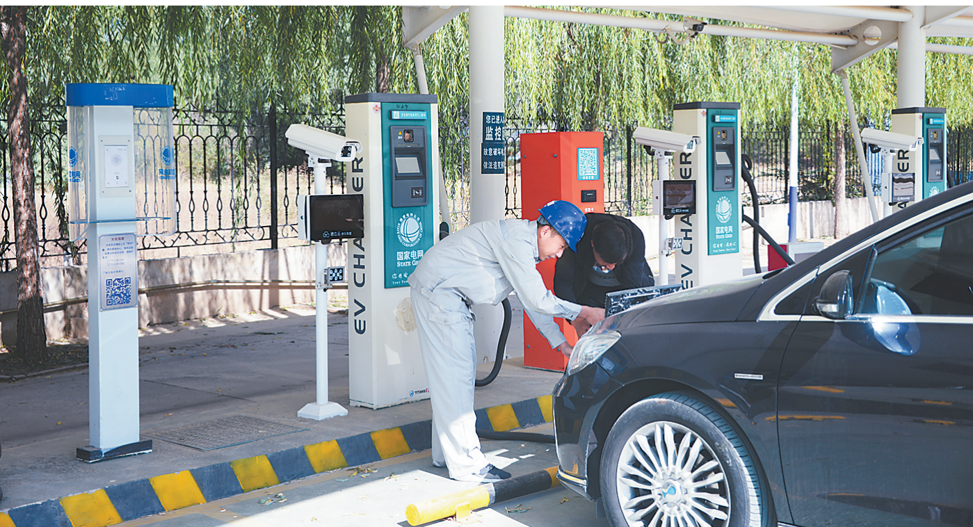
近日,在承德市高新区的一个充电站,供电公司的工作人员指导市民给电动汽车充电。为推进新能源汽车发展,助力大气污染防治工作,承德市全面推进充电基础设施建设。到2020年,全市将基本建成适度超前、车桩相宜、智能高效的充电基础设施体系。截至目前,全市已建设98座充电站、654个充电桩。 记者 陈宝云 通讯员 丁慧靓摄
