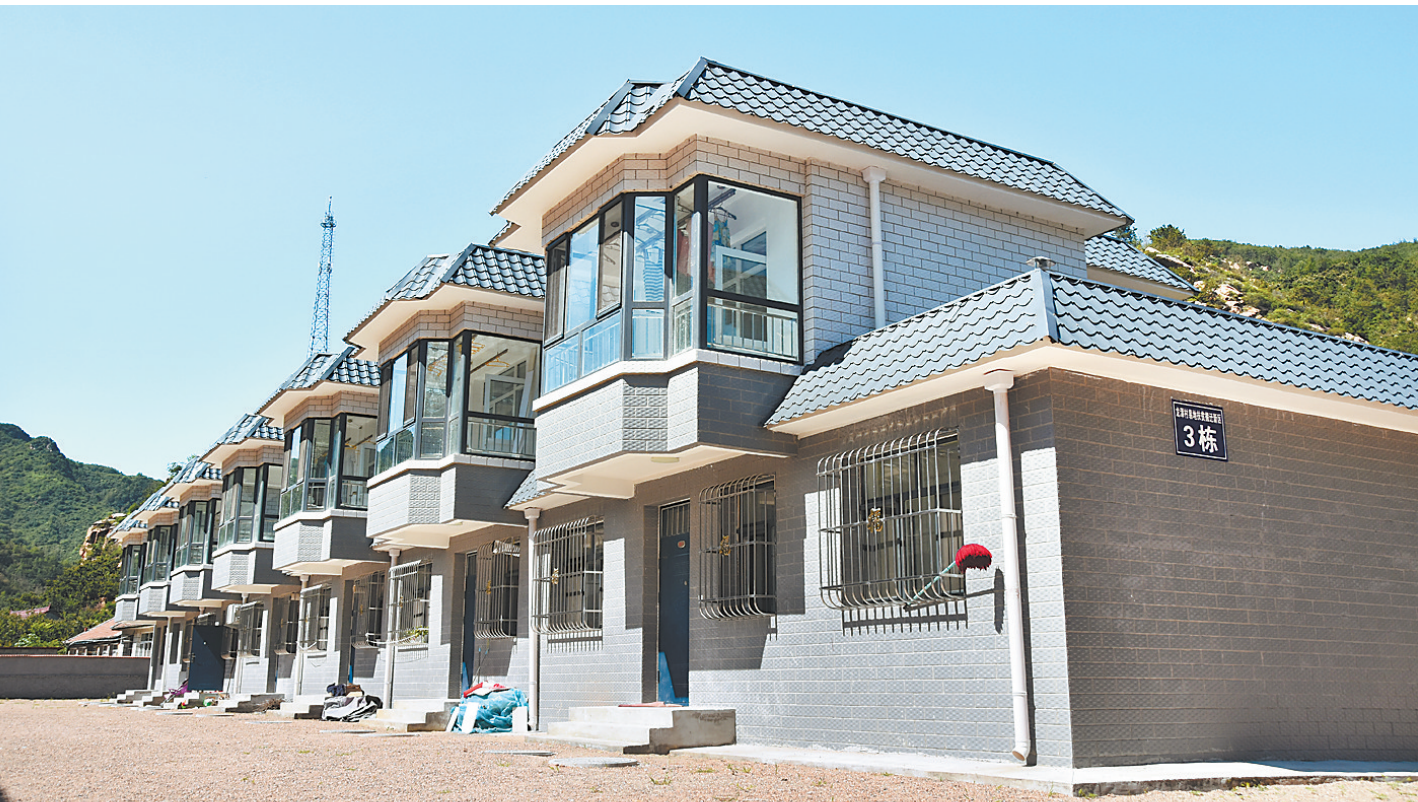
青龙满族自治县龙潭村易地扶贫搬迁点的二层住宅楼前宽敞平坦。2016年以来,该县易地搬迁涉及15个乡镇46个村,规划建设34个集中安置小区目前已全部竣工,搬迁户全部领取了新房钥匙。记者 孙也达 通讯员 田立民摄
