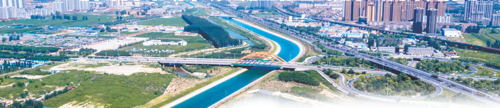
南水北调中线一期工程石家庄市段。(资料片) 南水北调中线建管局河北分局供图
