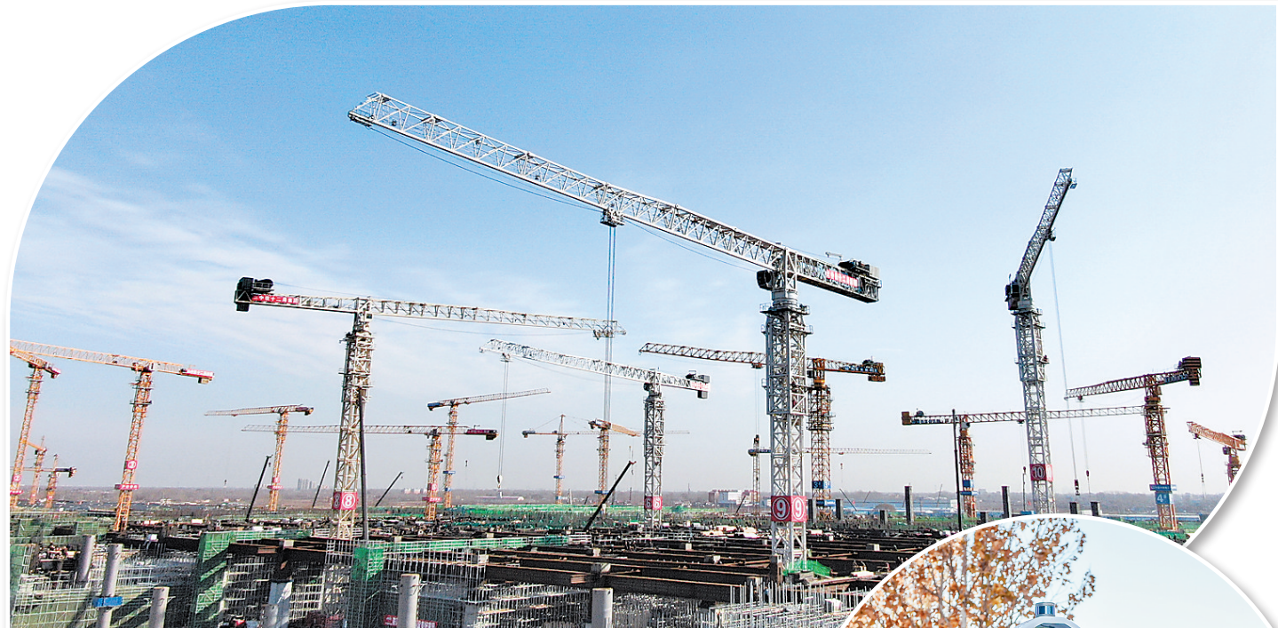
▲12月18日,建设中的雄安高铁站站房。
