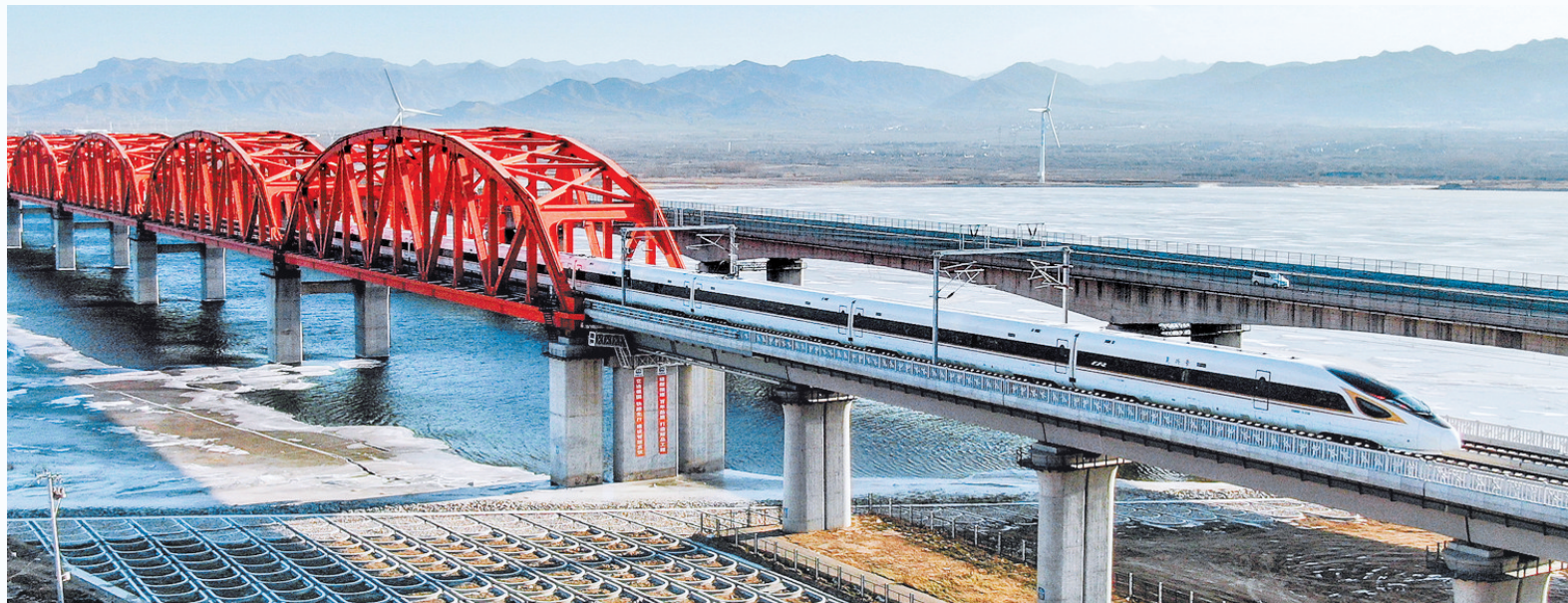
12月30日,一列复兴号动车组列车驶过京张高铁官厅水库特大桥。当日,北京至张家口高速铁路开通运营,崇礼铁路同步通车。 记者 赵杰摄
