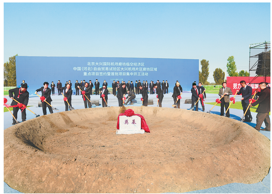
2019年10月26日,廊坊临空经济区首批6个重点项目集中开工。
